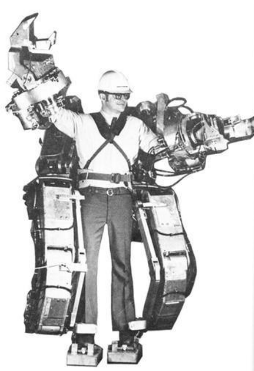
Foto: Museum of Innovation and Science/GE Reeports Eksoskelet družbe General Electric, znan kot Hardiman.
